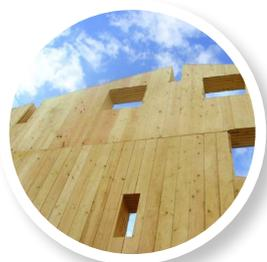
**MHM** è una tecnica simile all'X-lam con l'importante differenza che le tavole in legno disposte a strati incrociati sono unite tra loro mediante chiodi in alluminio ad aderenza migliorata. La stratigrafia della parete viene completata con le stesse modalità descritte per la parete a Telaio e in X-lam.
