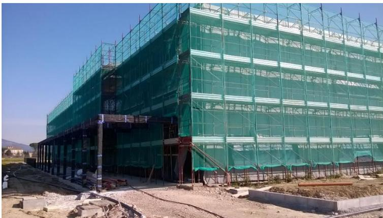
Fig. 16 - Protezione del perimetro esterno dell'edificio con teli impermeabili traspiranti
