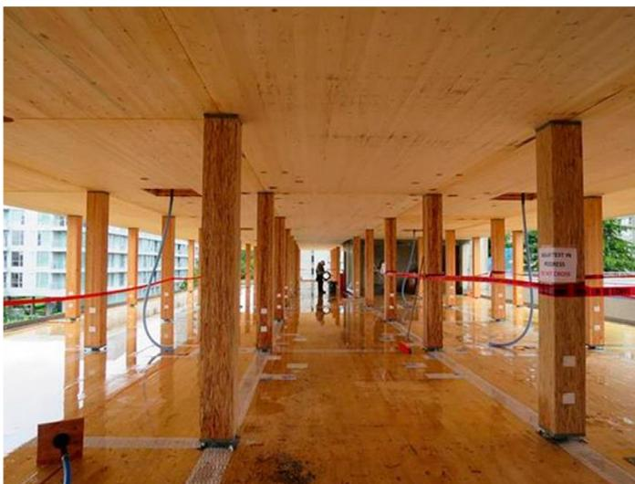
Fig. 20 - Brock Commons: fase di cantiere a seguito di nubifragio
