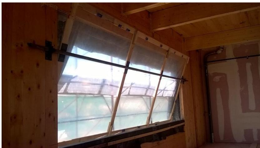
Fig. 17 - Infissi provvisori realizzati per proteggere le strutture durante il cantiere. Anche il controllo della temperatura e dell'umidità dell'aria all'interno del cantiere è particolarmente importante per prevenire possibili condizioni di degrado. A questo proposito una soluzione semplice ed economica è quella di posizionare dei termometri e degli igrometri in maniera tale da monitorare le condizioni ambientali.
