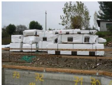
Fig. 21 - Teli di protezione e materiale stoccato sollevato da terra
