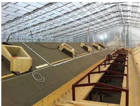
Fig. 23 - Protezione totale con teli provvisori
