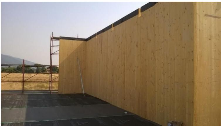
Fig. 15 - Protezione delle teste delle pareti con guaine traspiranti durante il cantiere
