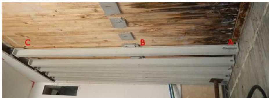
*Marcescenza del solaio solo sulla parte terminale A-B. Il solaio prosegue alla sinistra del punto C essendo la parete adiacente non strutturale. Profilati IPE fissati con viti tutto filetto. I profilati IPE vengono dapprima fissati al muro nel punto A e spessorati nel punto B. Il profilato nel punto C risulta quindi distanziato dal solaio; in tale punto il profilato viene fissato e serrato al solaio con viti verticali in modo tale da mettere subito in carico l'intervento*
