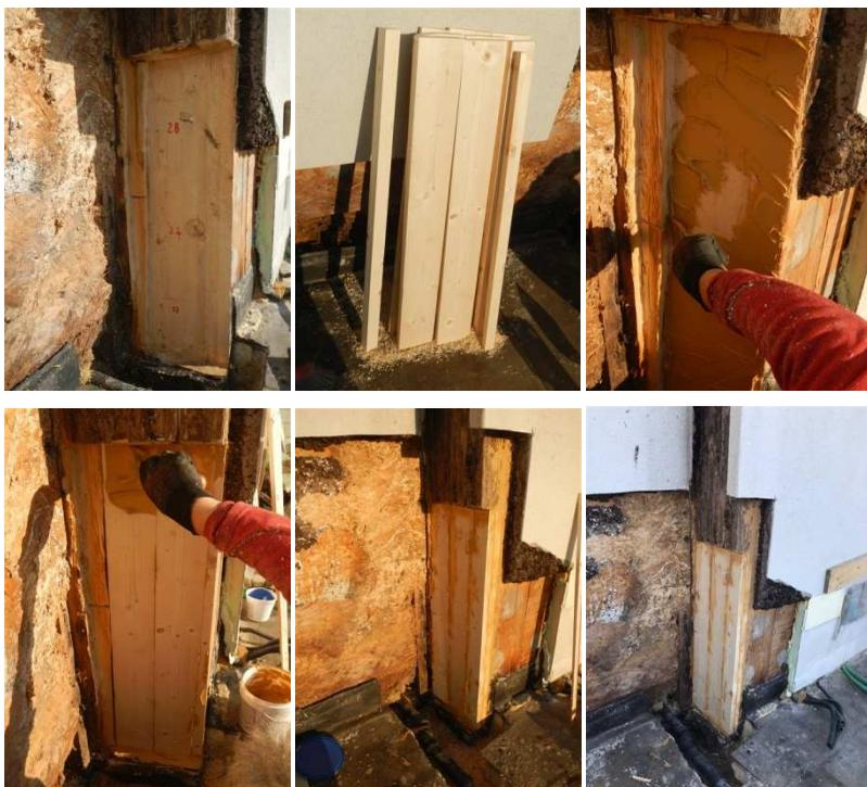
*Dapprima si elimina la parte degradata realizzando una nicchia squadrata ed a superfici piane; si preparano le tavole per la realizzazione della protesi avendo cura di provarle prima nella nicchia e poi riporle rispettando l'ordine di montaggio; ciascuno strato viene incollato con malta epossidica e schiacciato per mezzo di viti orizzontali in modo da schiacciare le tavole sul legno esistente e fra loro*
