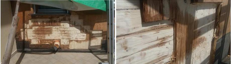
Intervento su di una parete CLT sottofinestra; la rimozione delle parti degradate avviene per l'intero spessore di ciascuno strato, lasciando i contorni scalettati. La ricostruzione sarà eseguita utilizzando tavole dello stesso spessore dello strato rispettando la direzione della fibratura di ciascuno strato
