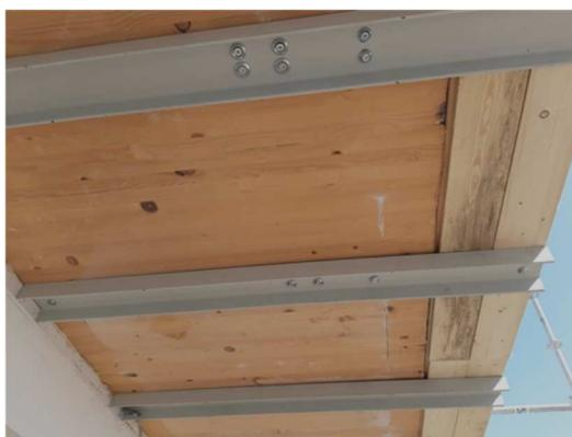
*Profilati ad U fissati con viti verticali. La ricostruzione in testa è fatta con tavole di legno incollate che però, essendo sostenute dalle travi di acciaio, non necessitano di particolare cura nell'ancoraggio con il pannello CLT esistente. La ricostruzione con tavole è leggermente sporgente all'intradosso in modo tale che, forzando le travi di acciaio contro il pannello CLT per mezzo delle viti, il sostegno diventi attivo*
