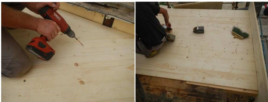
Fissaggio del pannello multistrato estradossale a cavallo fra CLT e travetti, si utilizzano viti a inclinazione contrapposta sui travetti e sul pannello CLT
