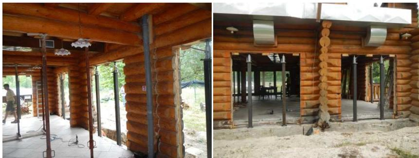
Smontaggio degli infissi, puntellazione di forza della struttura mediante martinetti idraulici su pilastri di acciaio e puntellazione di sicurezza mediante puntelli regolabili
