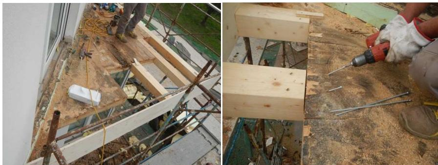
Dopo aver eliminato la parte degradata si procede a ricostruirla ponendo in opera dei monconi di travi lamellari. A destra il fissaggio a taglio fra CLT e nuovi travetti con viti tutto filetto inclinate
