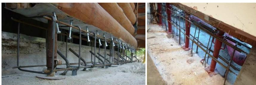
*Basette regolabili a perdere; guaina adesiva alla base della parete; viti di collegamento fra il nuovo cordolo e la parete in legno; perforazioni armate di collegamento fra la fondazione ed il nuovo cordolo; armatura di confezionamento nuovo cordolo*
