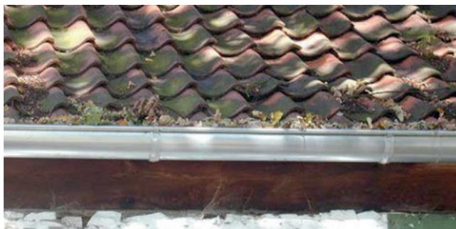
Fig. 7 – Grondaia ostruita nei processi di deflusso dell'acqua meteorica
