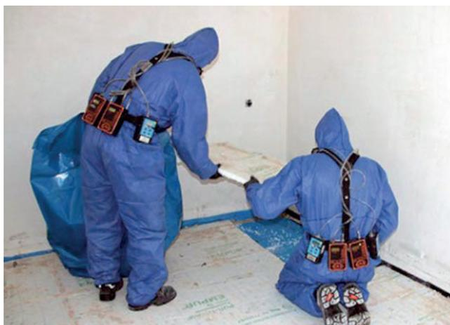
Fig. 11 – Esempificazione dei processi di risanamento dei locali e misure di DPI per la mitigazione del rischio fronte intossicazione del personale.
