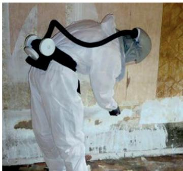
Fig. 12 – Azione di ripristino dei locali da muffa su strutture in legno - esempio.
