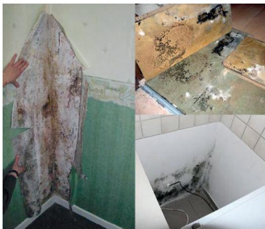
Fig. 1 – Esempi di danni da "muffa" visibile attraverso un'ispezione delle superfici
