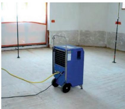
Fig. 13 – Esempio - Deumidificatore a seguito di intervento di ripristino dei locali
