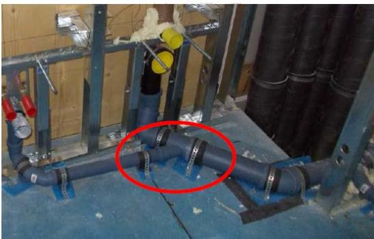
**Figura 2.10** Corretto fissaggio della tubazione al solaio.
