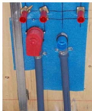
**Figura 2.9 Presenza di protezione per la struttura in legno.**
