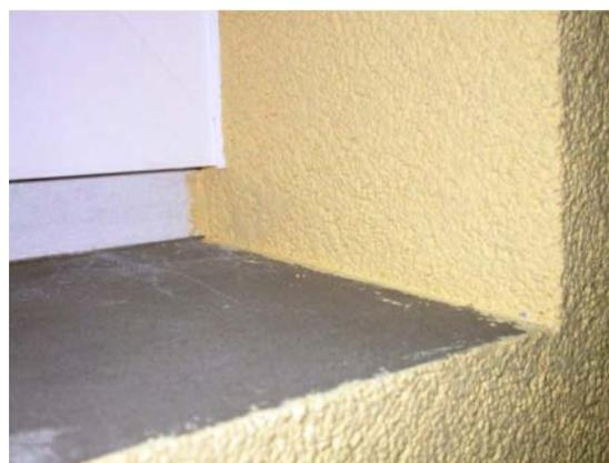
**Figura 2.2 Seconda superficie impermeabile del parapetto portato finito (boiacche impermeabilizzanti incluso il rialzo laterale già intonacato).**
