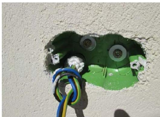
**Figura 2.17: Sigillatura del passaggio esterno di un cavo.**
