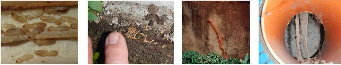
**Figura 2.18:** da sinistra: due foto di termiti; galleria su un muro; gallerie pendule in un canale di ventilazione.
