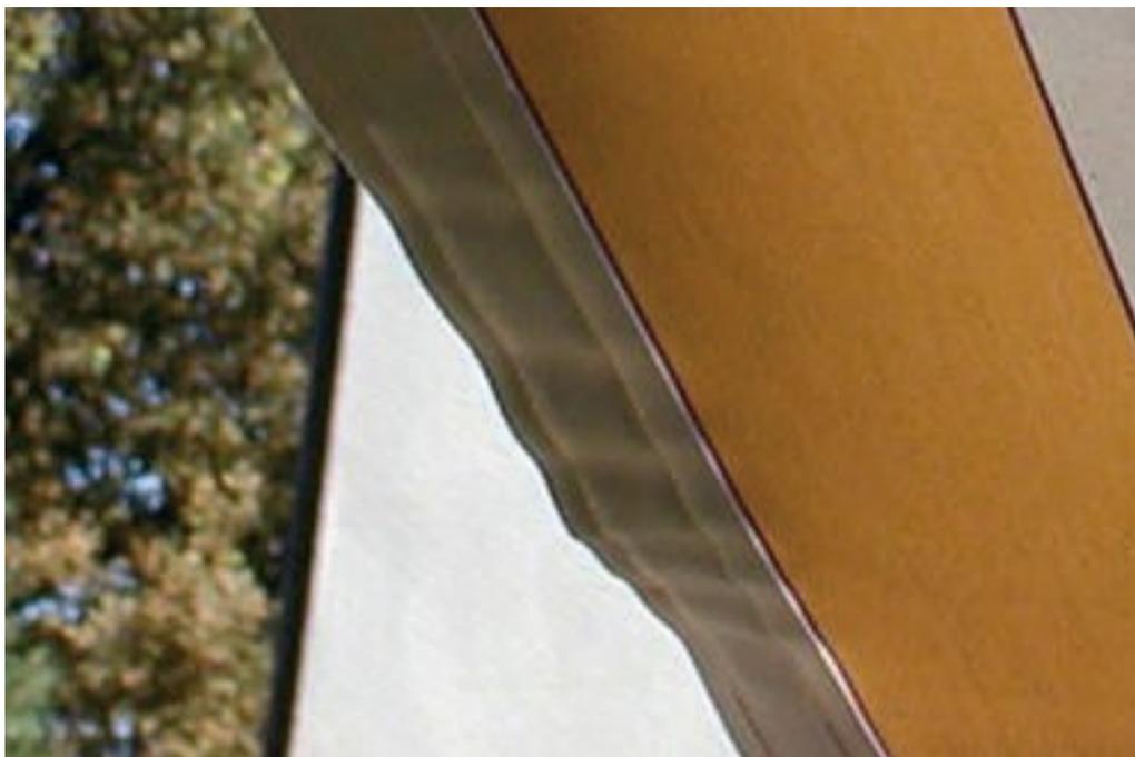
**Figura 9.1.9** Increspature e sovradimensionamenti consentiti nell'area delle cuciture
