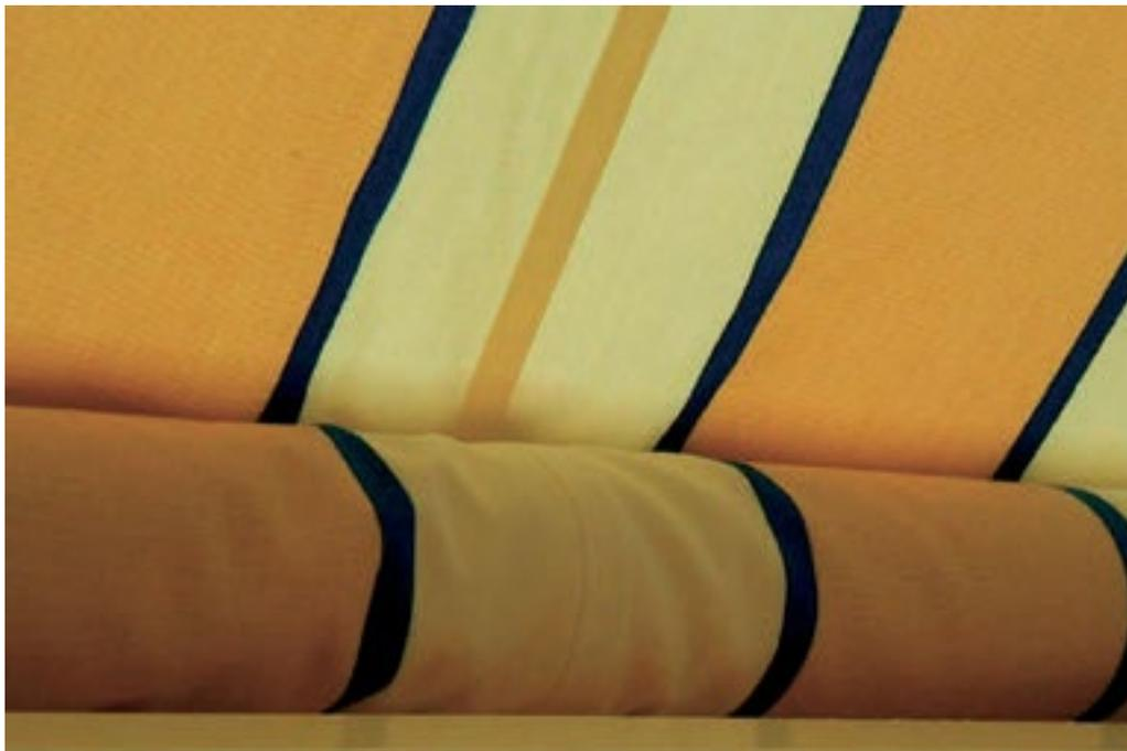
**Figura 9.1.12** Pieghie di compressione e di avvolgimento consentite sul rullo di avvolgimento
