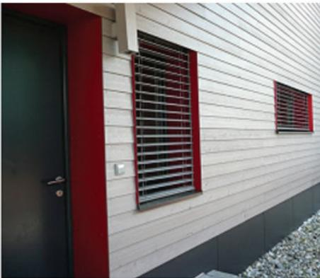
**Figura 1.23. Edificio realizzato in legno con elementi protetti alla base e rialzati da terra**
