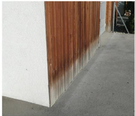
**Figura 1.24. Edificio realizzato in legno con elementi esposti (non protetti) al degrado nella zona di attacco a terra**
