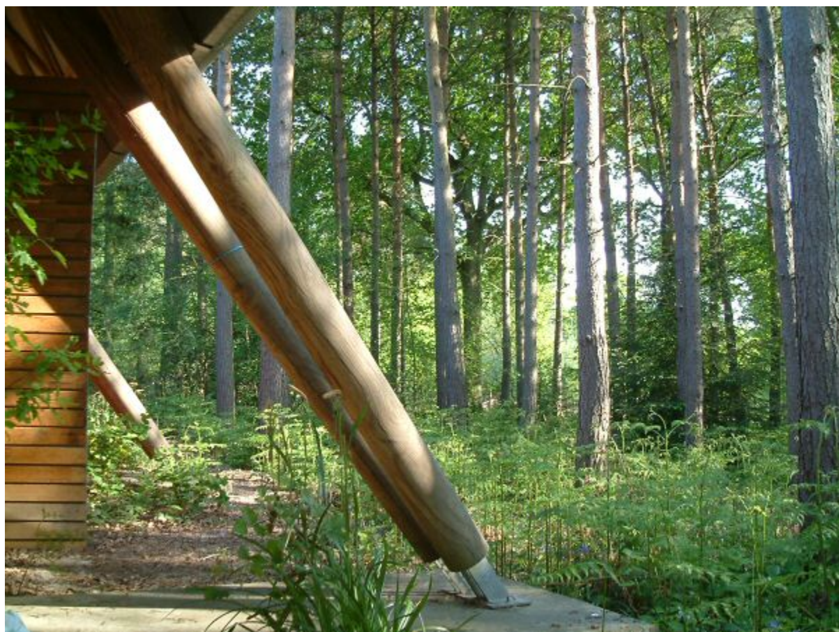
Figura 2.8 – Elementi strutturali in castagno a sezione circolare – non solo differenze anatomiche e di prestazioni, ma differenti tipi di legno mostrano differenti classi di durabilità nei confronti del degrado di tipo biotico (courtesy Woodland Enterprise Centre).
