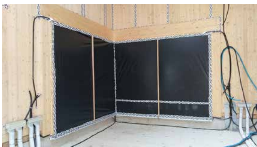
Figura 8.56 – Preparazione di un test Blower Door Metodo B per un edificio con struttura XLAM. Si possono notare i teli utilizzati per sigillare le aperture prima della posa degli infissi.
