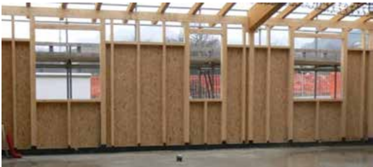
Figura 7.12 - Vista frontale di più pareti paltform assemblate.
