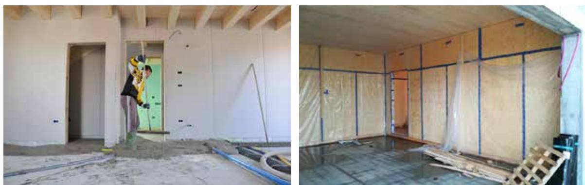
Figura 8.22 – L'umidità negli edifici in legno può anche derivare da lavorazioni "umide" (sottofondi ad esempio ma anche intonaci), così come da fenomeni meteorologici intensi durante la costruzione.
