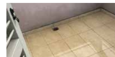
Figura 7.24 - Balcone non coperto con grave problema di ristagno delle acque meteoriche.
