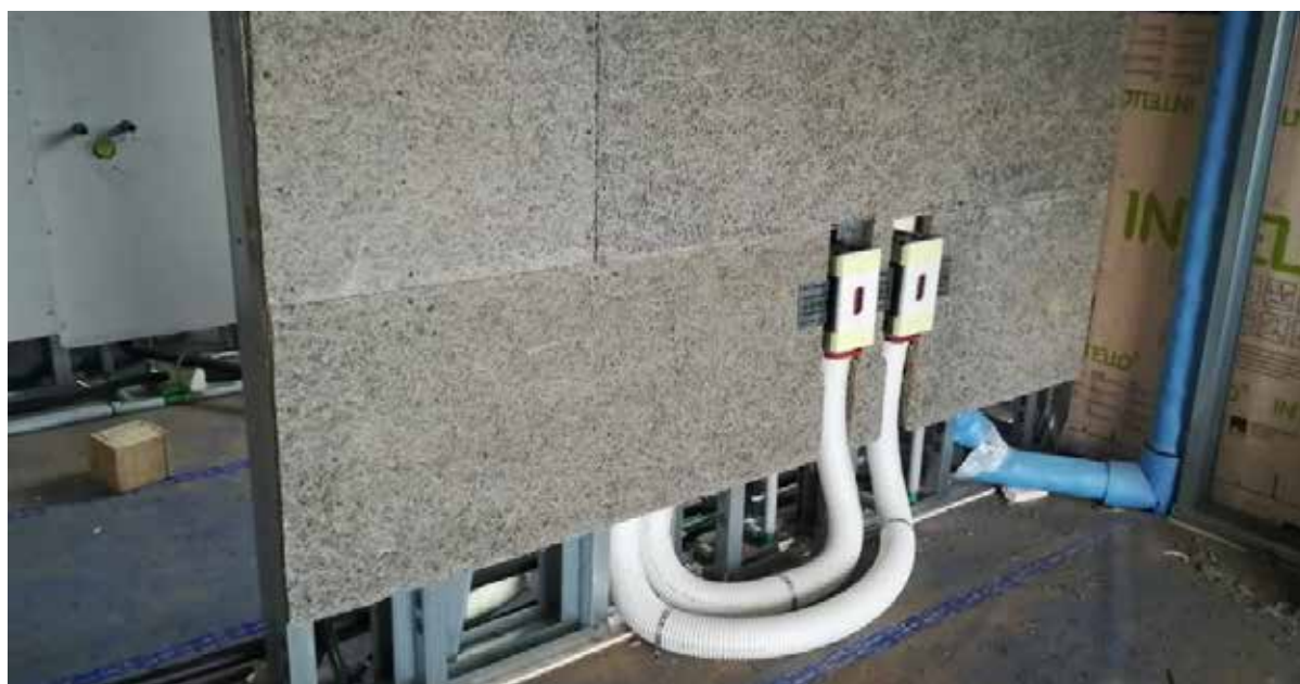
Figura 8.34 – Edificio residenziale in legno – si noti l'utilizzo di pareti interne in legno mineralizzato come pannello porta intonaco per aumentare il valore di capacità Areica interna degli ambienti.
