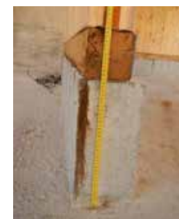
Figura 7.18 - Cordolo di rialzo in c.a. e parete XLam su cordolo in legno.
