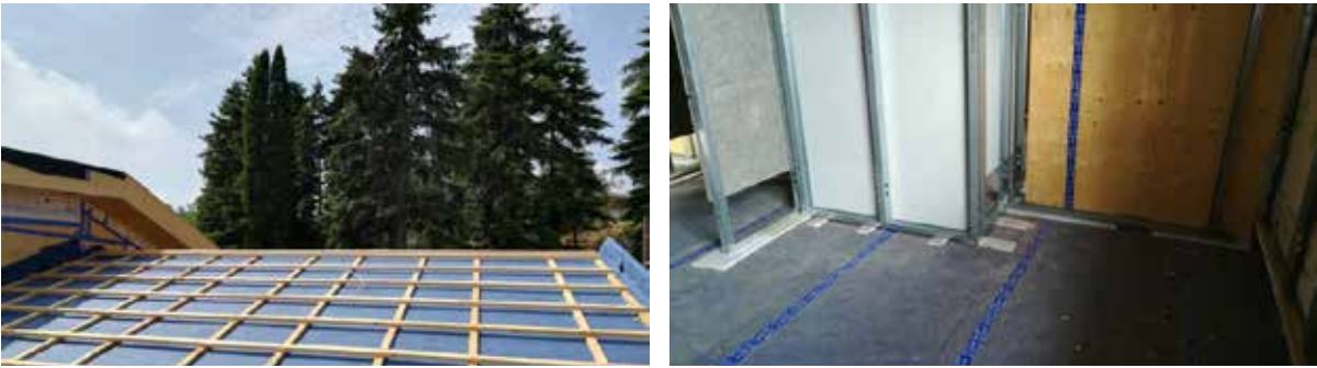
Figura 8.46 – Telo traspirante con funzione di tenuta al vento e di protezione occasionale dalla pioggia (sinistra) e telo di protezione del solaio XLAM interpiano per l’umidità da getti di riempimento umidi (destra).
