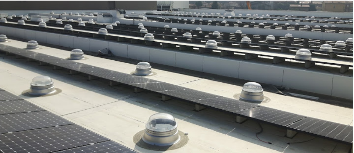
Figura 8.33 – Utilizzo di una guaina riflettente ad alto valore SRI su un moderno edificio in legno.
