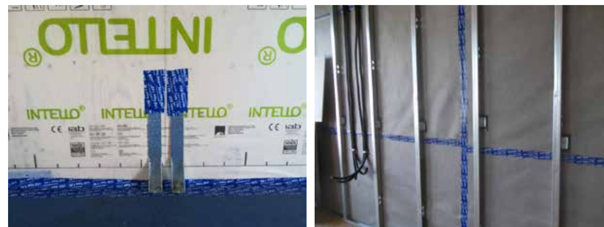
Figura 8.52 – (sinistra) La ferramenta, se non considerata, è un elemento serio di disturbo della continuità della tenuta all'aria, così come la struttura portante delle contro pareti (si notino i punti chiodo sul retro).
