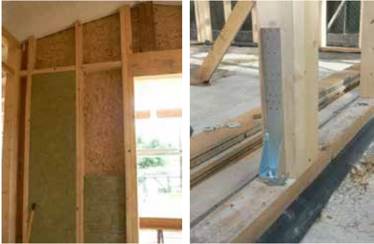
Figura 7.11 (destra) - Installazione Hold-down su parete platform
