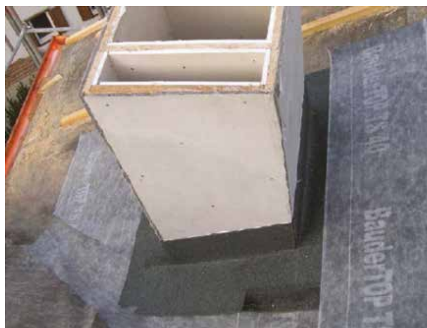
Figura 5.13 – Attività del carpentiere: posa della guaina impermeabile nell’intorno della canna fumaria
