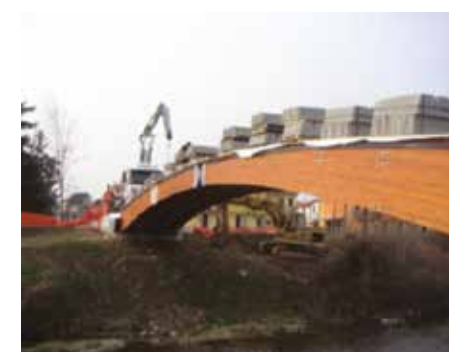
Figura 6.2 – EN 380 – Prova di carico su passerella in legno lamellare.
