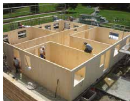
Figura 8.3 – Gli edifici con struttura in XLAM sono caratterizzati da setti simili come percezione ad edifici a muratura portante.
