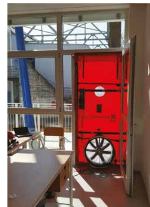
Figura 8.54 – Test Blower Door in un edificio scolastico in legno (Scuola G.Verdi Collecchio).
