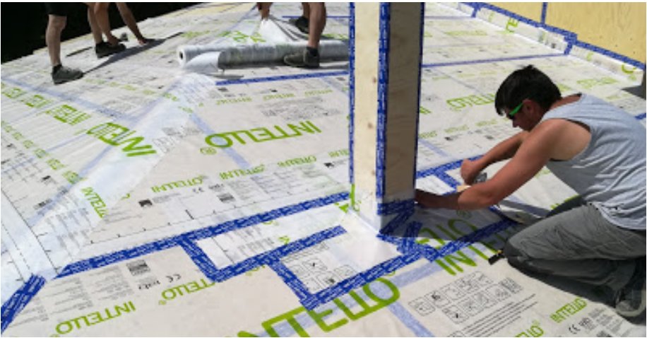
Figura 8.40 – Posa di un telo freno vapore e delle relative nastrature.
