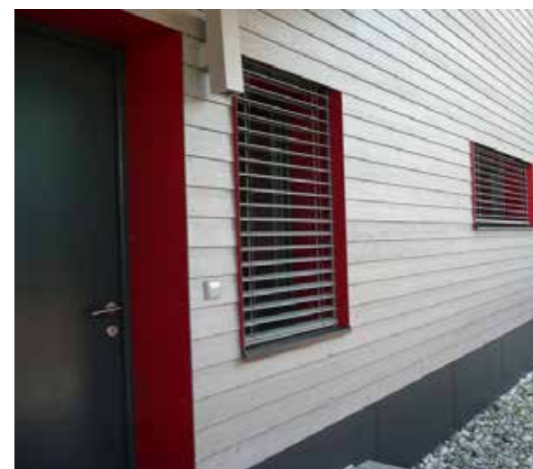
Figura 5.11 - Edificio realizzato in legno con elementi protetti alla base e rialzati da terra (esempio)
