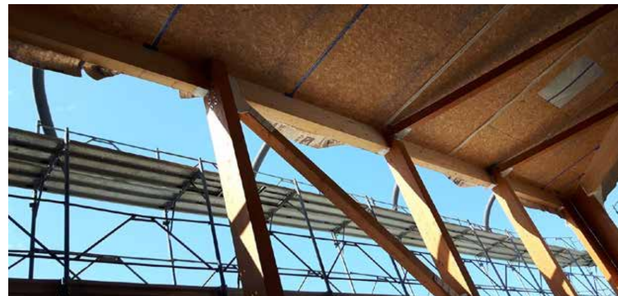
Figura 8.42 – Per realizzare un involucro termico, i componenti non solo si sommano, ma si dispongono per sfruttare al massimo le potenzialità energetiche offerte dal clima e dalle specificità del luogo di costruzione.
