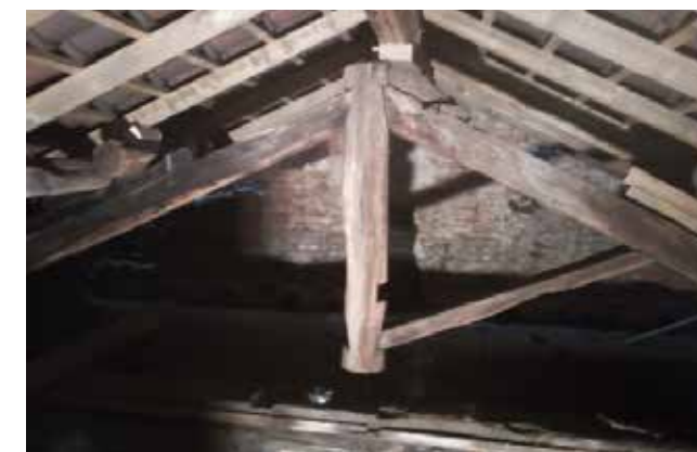
Figura 4.12 – degrado di tipo meccanico – sfilamento della saetta spesso conseguenza del dissesto del dente di connessione tra puntone e catena.
