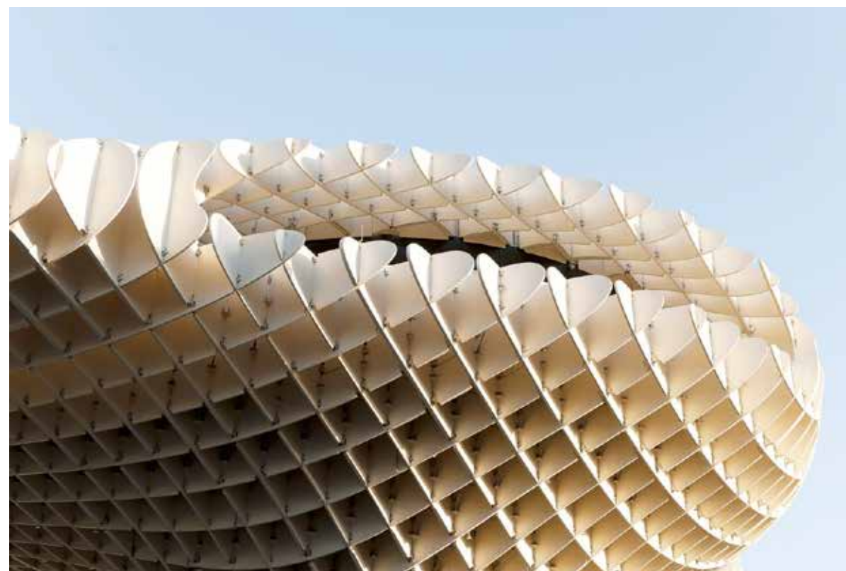
Figura 5.14 – Metropol Parasol – Siviglia – particolare della struttura LVL
