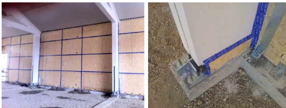
Figura 8.53 – Nastrature sui pannelli OSB e sull'attacco delle colonne perimetrali di un edificio in legno. Fonte COOP Estense – SMK Rovereto sul Secchia (MO).
