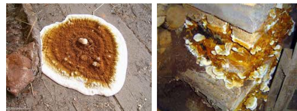
Figura 2.18 - Micelio di Serpula lacrymans in diversi stadi di sviluppo.
