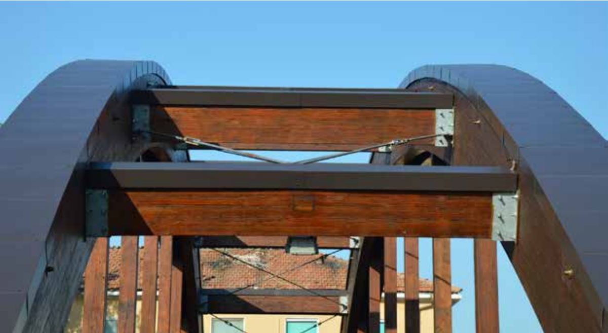
Figura 2.11 - Passerella in legno e presenza di scossaline metalliche a protezione degli elementi portanti. Strutture in classe di servizio 3 necessitano di particolari costruttivi specifici e di assicurare una razionale manutenzione durante la vita nominale dell'opera.
