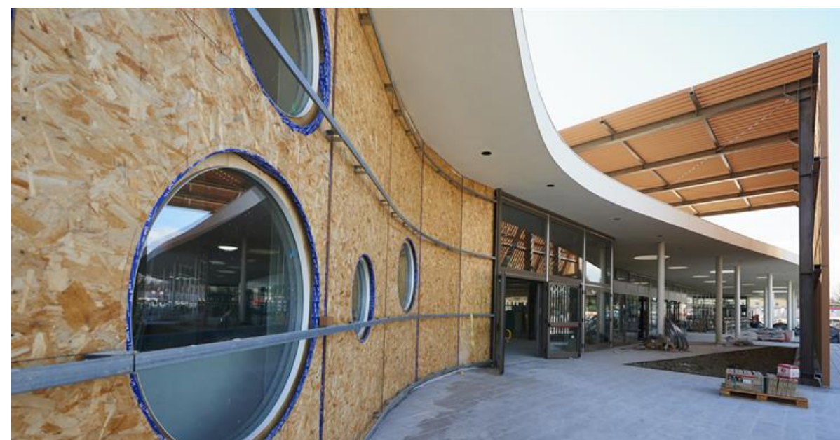
Figura 8.65 – COOP Alleanza 3.0 Formigine – esempio di edificio in legno in cui diverse strategie per il raffrescamento passivo sono state utilizzate per realizzare il primo supermercato in legno LEED di Italia (courtesy Sistem Costruzioni Spa).
