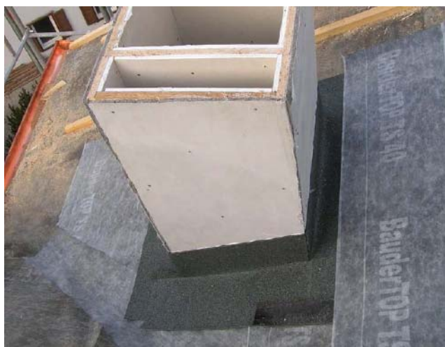
Figura 7.29 – Posa della guaina impermeabile (esempio)
