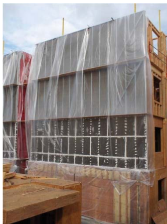
Figura 6.7 - Protezione parziale con teli provvisori sulla parete esposta a venti dominanti e pioggia di stravento
