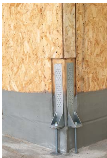
Figura 7.3 – Sigillatura del giunto parete esterna / cordolo di attacco a terra tramite guina liquida. Si veda nel presente caso la disposizione degli hold-down (posizione corretta in quanto soggetti a "lavorare a trazione" e non a compressione)
