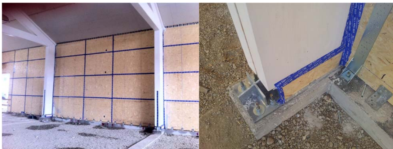
Figura 7.40 – Nastrature sui pannelli OSB e sull’attacco delle colonne perimetrali di un edificio in legno. Fonte COOP Estense – SMK Rovereto sul Secchia (MO).
