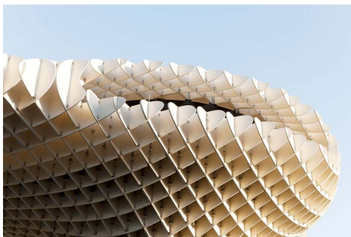
Figura 1.1 – Metropol Parasol – Siviglia – particolare della struttura LVL
