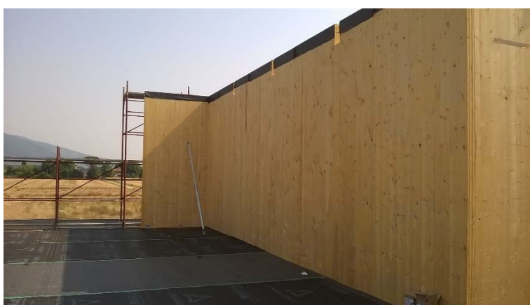
Figura 6.1 Protezione delle teste delle pareti con guaine traspiranti durante il cantiere (esempio)
