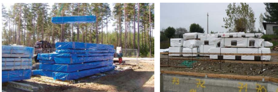
Figura 5.4 – Stoccaggio materiale in cantiere (esempio)
