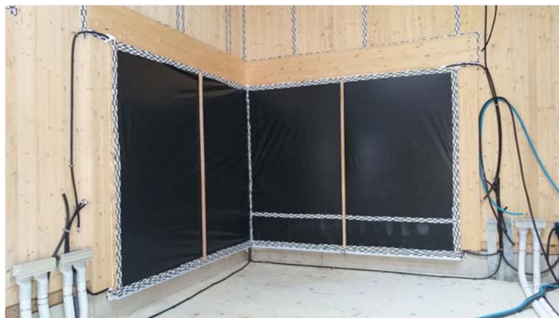
Figura 7.41 – Preparazione di un test Blower Door Metodo B per un edificio con struttura XLAM. Si possono notare i teli utilizzati per sigillare le aperture prima della posa degli infissi.
