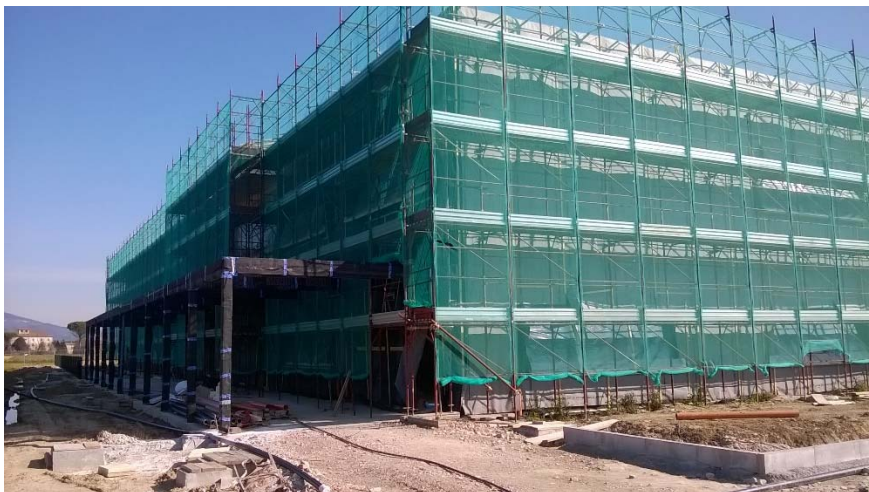
Figura 6.2 Protezione del perimetro esterno dell'edificio con teli impermeabili traspiranti
