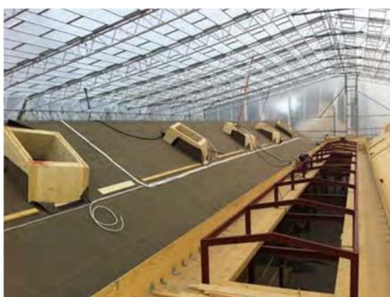
Figura 6.8 - Protezione totale con teli provvisori
