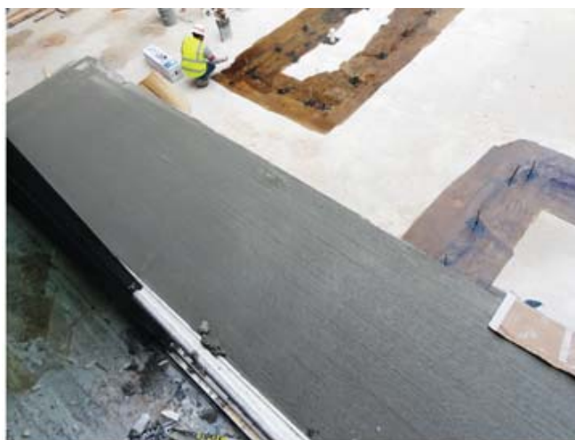
Figura 7.20 – Il getto di calcestruzzo è realizzato con attenzione alla rasatura per assicurare una corretta pendenza. Possono essere posti nel calcestruzzo fresco giunti di dilatazione per limitare le fessure da ritiro nella soletta
