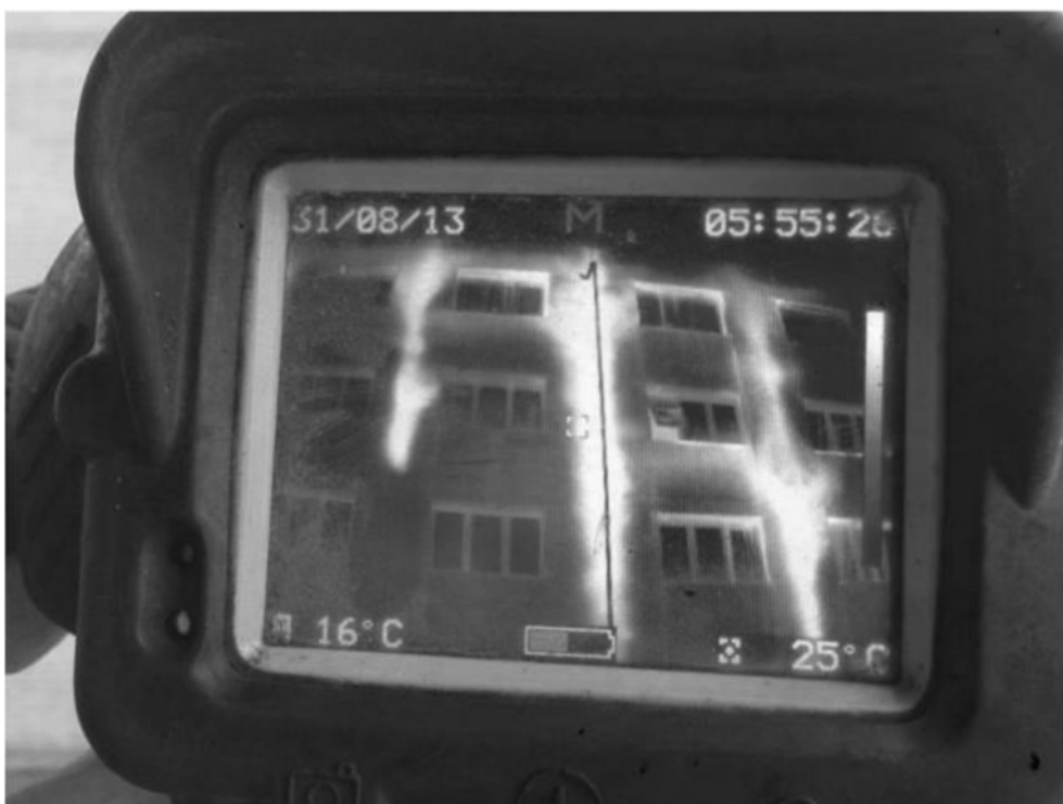
Figura 6.12 – Immagine termografica – sviluppo e propagazione dell’incendio attraverso i cavedi tra moduli prefabbricati
