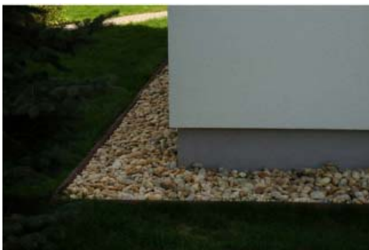
Figura 7.6 – Zoccolatura ben arretrata; si noti lo strato di ghiaia intorno all'edificio per assicurare una ridondanza delle misure di protezione alla struttura che assicura un drenaggio delle acque meteoriche.
