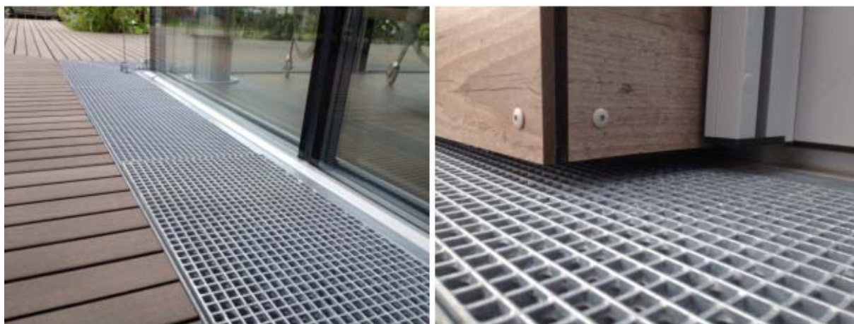
Figura 7.1 – Posa del grigliato in corrispondenza dell'attacco a terra
