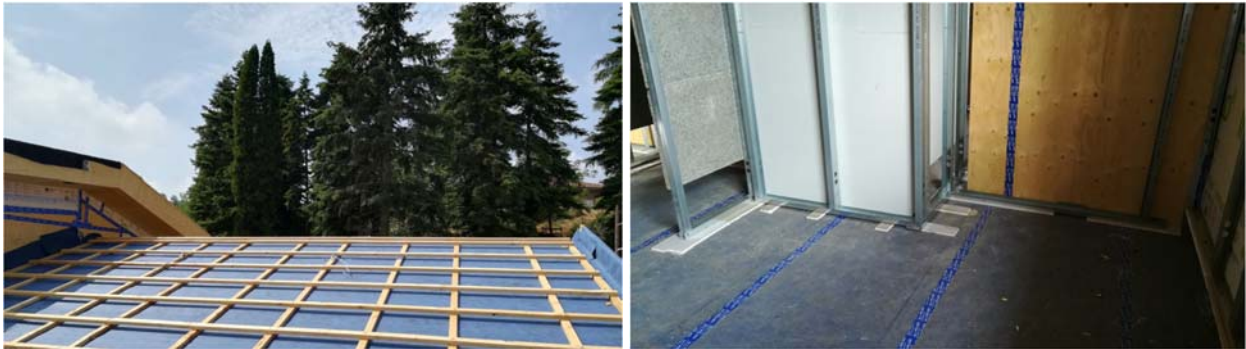
Figura 7.33 – Telo traspirante con funzione di tenuta al vento e di protezione occasionale dalla pioggia (sinistra) e telo di protezione del solaio XLAM interpiano per l'umidità da getti di riempimento umidi (destra).
