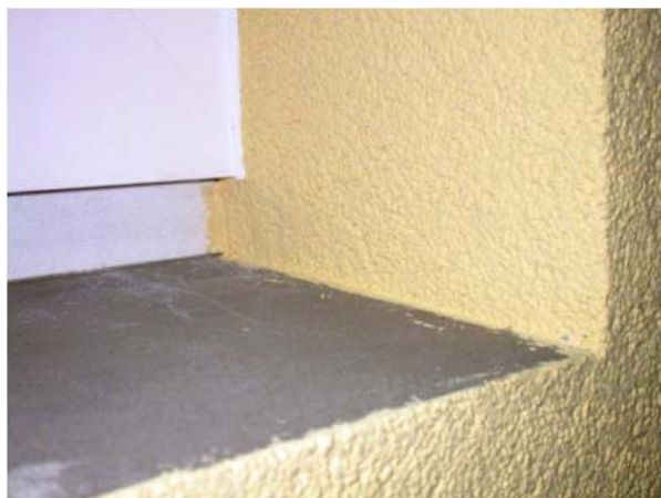
Figura 7.10 – seconda superficie impermeabile del parapetto trattato finito
