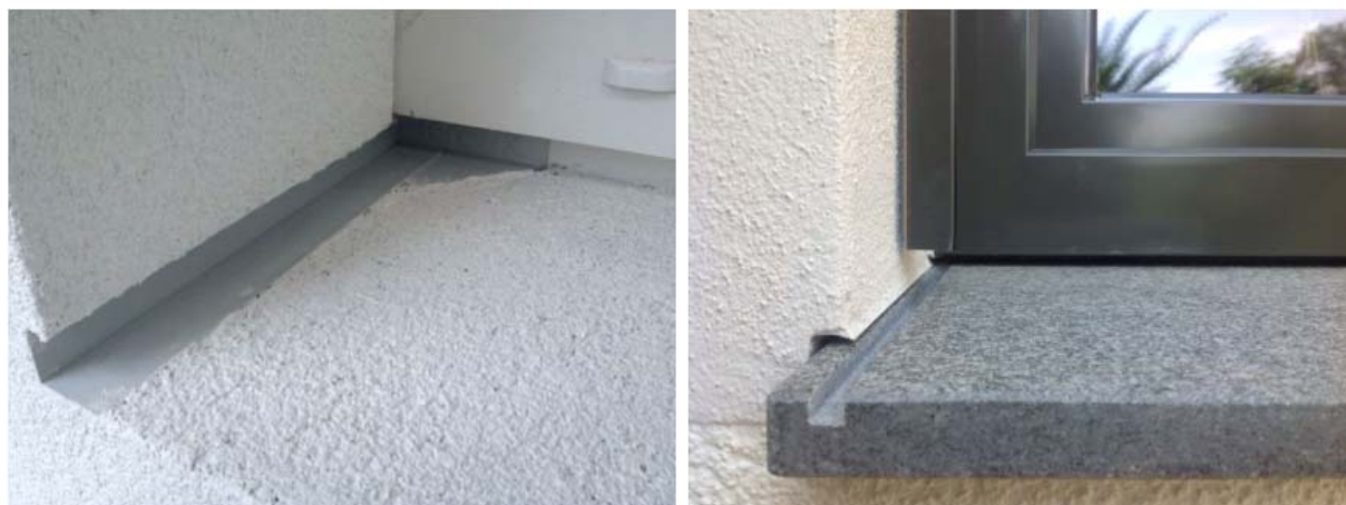
Figura 7.11 – a sinistra: profilo per l'intonaco come preparazione per montaggio del davanzale con una seconda superficie drenate; a destra: successivamente con davanzale in pietra infilato e montato. Si noti inoltre la fresatura sul bancale in modo da favorire il deflusso delle acque verso l'esterno.
