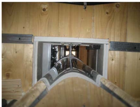
Figura 7.28 – Passaggio camino in struttura a pannelli portanti
