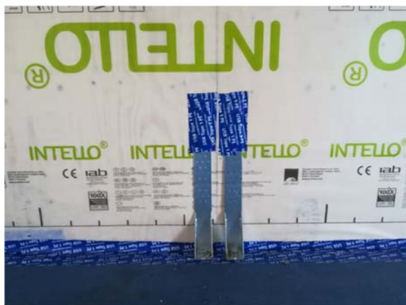
Figura 7.39 – (sinistra) La ferramenta, se non considerata, è un elemento serio di disturbo della continuità della tenuta all’aria, così come la struttura portante delle contro pareti (si notino i punti chiodo sul retro).
