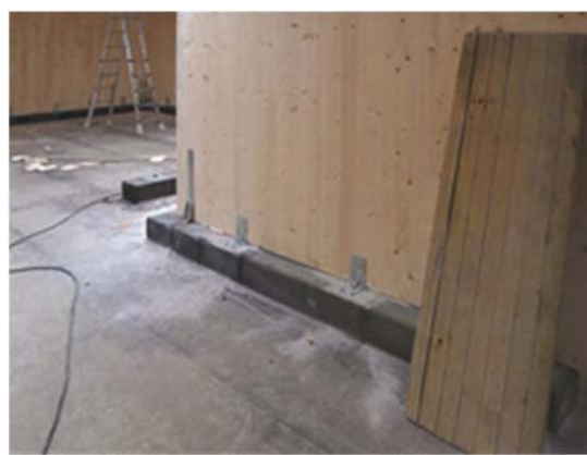
Figura 7.5 – Attacco a terra eseguito correttamente, la guaina bituminosa protegge il CLT dalla risalita dell'umidità per capillarità.
