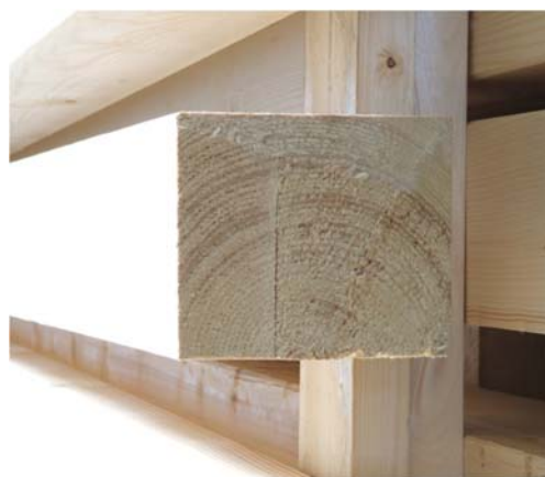
Figura 2.12 – Canastro sulla sezione trasversale, riconoscibile per il colore brunastro che segue gli anelli di accrescimento.
