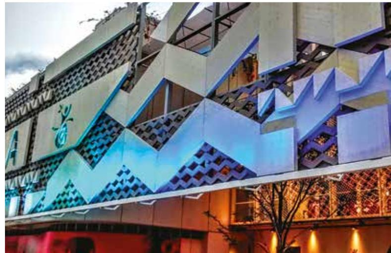
“compassi” in c.a., mentre i piani di calpestio sono costituiti da lastre in calcestruzzo, incastrate mediante barre filettate e unite alla struttura di copertura mediante tiranti in acciaio. La soluzione costruttiva adottata presenta una notevole complessità strutturale, sia per gli sbalzi delle travi sia per i carichi rilevanti richiesti sui solai.
