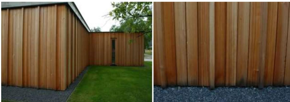
Fig. 5.12 – esecuzione di una facciata in legno von listelli (rivestimento) verticale senza prendere in considerazione particolari costruttivi adeguate. Sono visibili dopo poco tempo le prime variazioni cromatiche di color nerastro (segno evidente di sviluppo di ife fungine)
