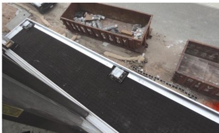
Fig. 5.30 – I profili a T vengono installati sul perimetro esterno, evitando di coprire con la guaina le contropiastre (annegate e predisposte per ricevere i montanti).
