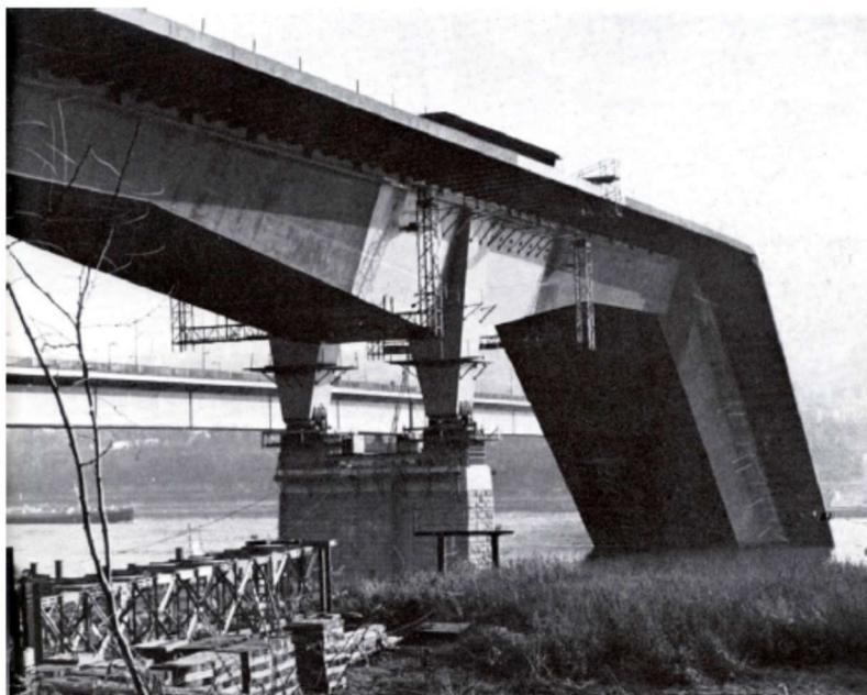
Fig. 6.3 - Collasso di una partizione di elemento tridimensionale in acciaio – Koblenz 1971
