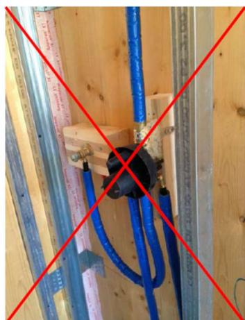
Fig 6.39 – assenza di protezione per la struttura in legno
