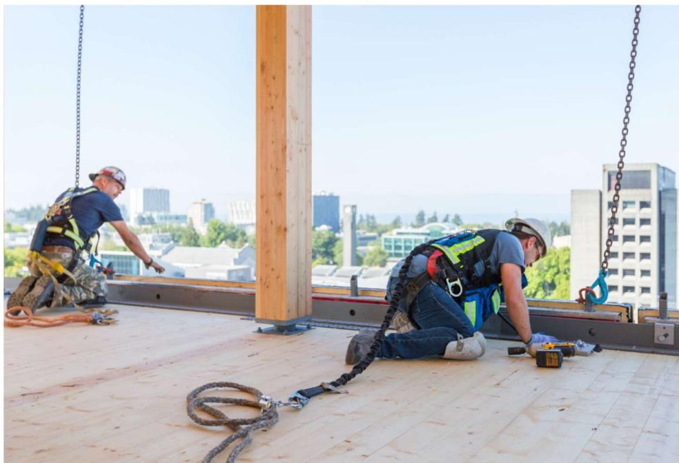
Fig. 7.12 – Fase di montaggio delle strutture prefabbricate e misure di protezione delle squadre
