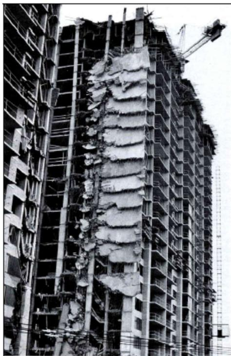
Fig. 6.2 – Collasso progressivo di un edificio multipiano in calcestruzzo armato dovuto alla rimozione prematura degli elementi di puntellamento – Virginia, 1973
