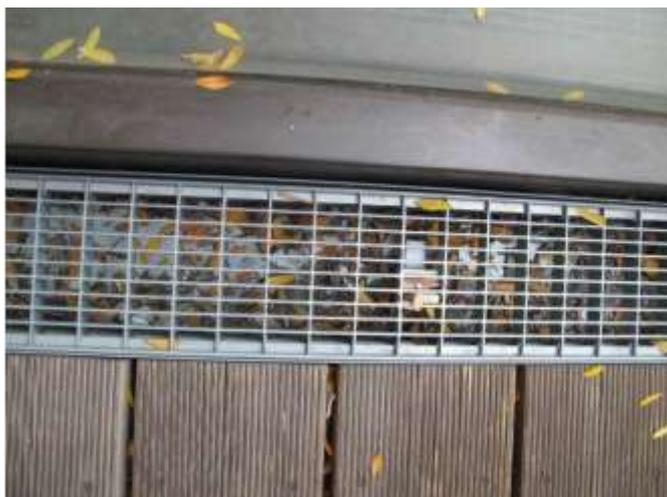
Fig. 5.13 – canaletta di scolo riempita con fogliame e sporcizia. Questa deve essere pulita e sottoposta a lavori di manutenzione regolarmente per garantire un funzionamento continuo
