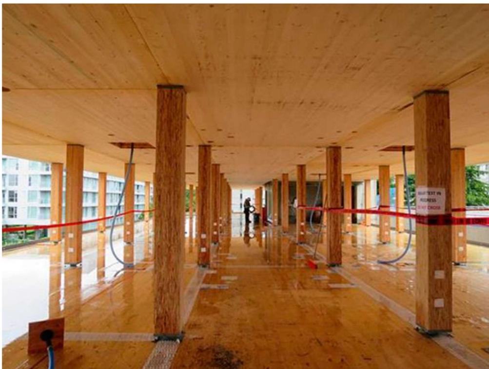
Fig. 6.13 – Brock Commons – Fase di cantiere a seguito di nubifragio
