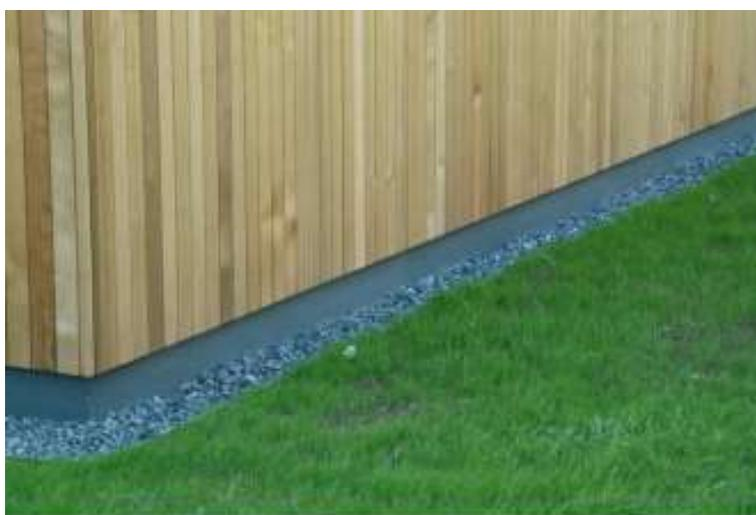
Fig. 5.11 – esecuzione di una facciata in legno con listelli (rivestimento) disposti in senso verticale con protezione contro la pioggia di rimbalzo adeguata ( $\geq 30$  cm altezza dello zoccolo esterno e letto di ghiaia per consentire il drenaggio della stessa).
