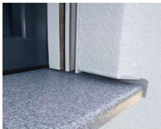
Fig. 5.24 – profilo guida per frangisole intonacato con raccordo laterale del davanzale ad intaglio retto. Tra il raccordo laterale del davanzale e il profilo guida del frangisole è necessaria una impermeabilizzazione tramite nastro sigillante butilico.
