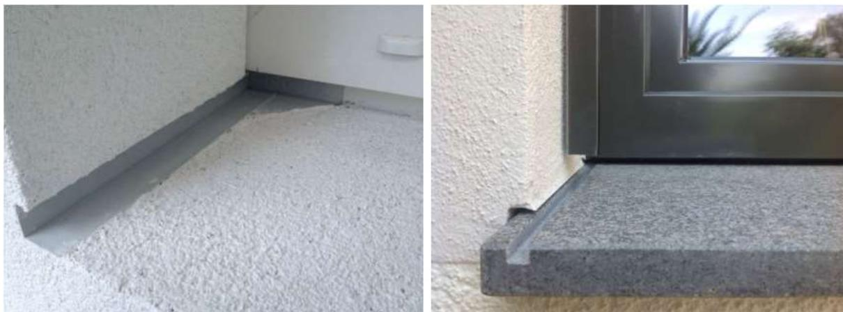
Fig. 5.21 – a sinistra: profilo per l’intonaco come preparazione per montaggio del davanzale con una seconda superficie drenate; a destra: successivamente con davanzale in pietra infilato e montato. Si noti inoltre la fresatura sul bancale in modo da favorire il deflusso delle acque verso l’esterno.
