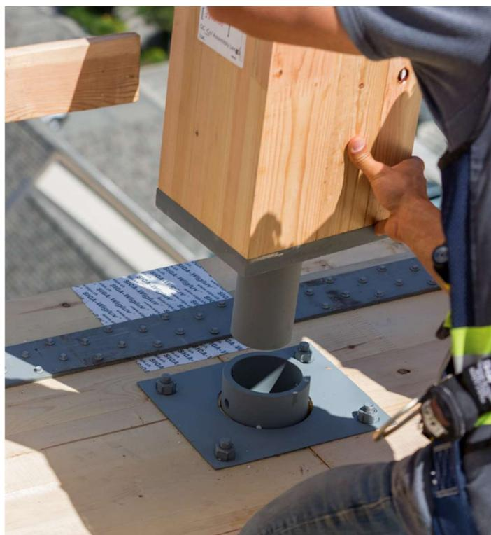
Fig. 7.11 – particolare di montaggio degli elementi in GLT (Courtesy British Columbia)
