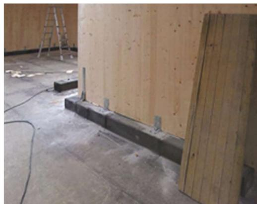
Fig. 5.5 – Attacco a terra eseguito correttamente, la guaina bituminosa protegge il CLT dalla risalita dell'umidità per capillarità.
