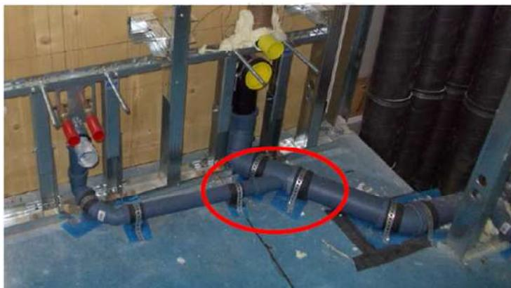
Fig 6.41 – corretto fissaggio della tubazione al solaio
