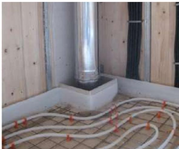
Fig. 5.53 – passaggio camino in struttura a pannelli portanti
