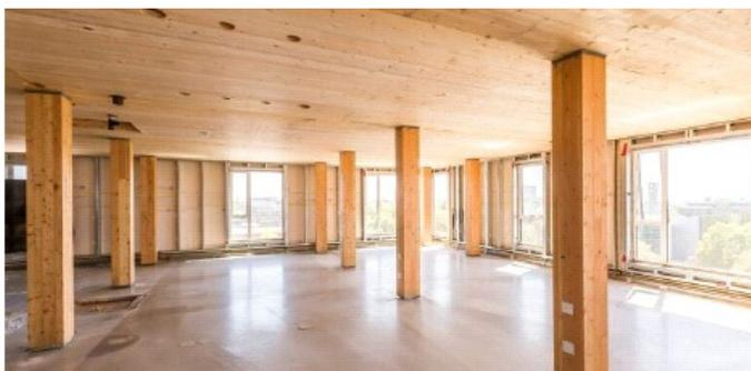
Fig. 7.12 – elementi in legno senza protezione
