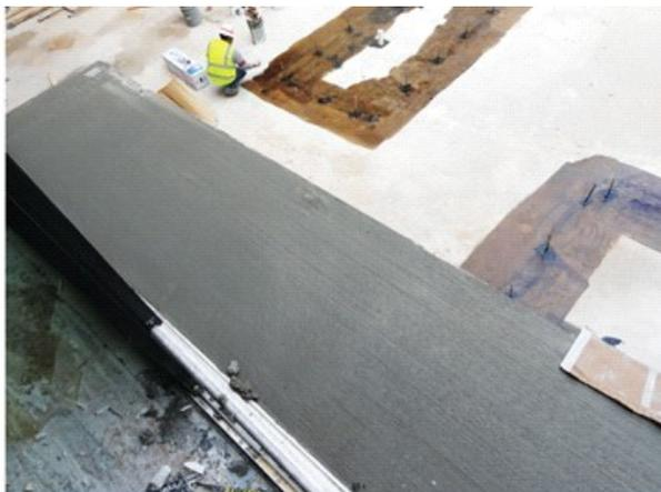
Fig. 5.33– Il getto di calcestruzzo è realizzato con attenzione alla rasatura per assicurare una corretta pendenza. Possono essere posti nel calcestruzzo fresco giunti di dilatazione per limitare le fessure da ritiro nella soletta.
