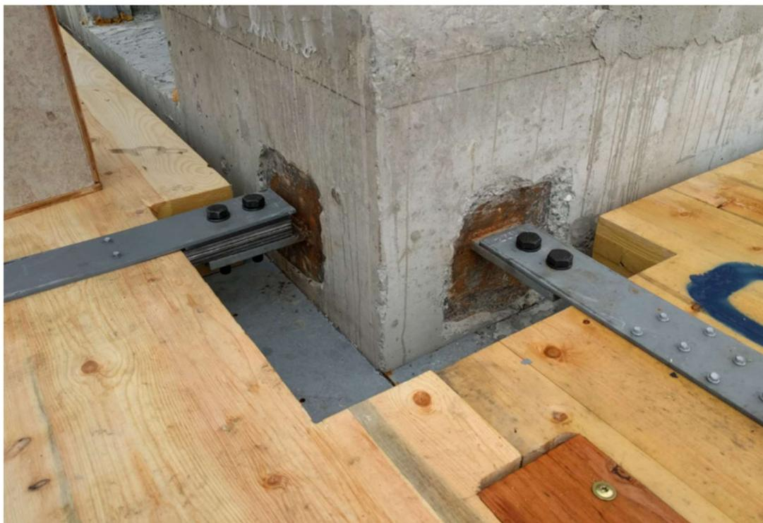
Fig. 7.10 – montaggio e particolari di connessione tra elementi in CLT e core in c.a. (Courtesy British Columbia)
