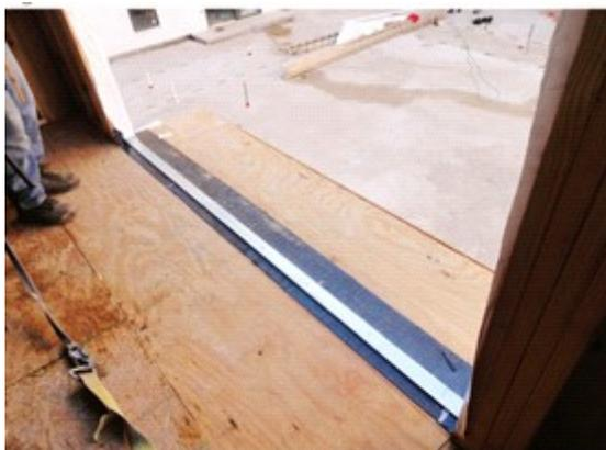
Fig. 5.27 - La scossalina della porta è in continuità con il sistema impermeabilizzante della parete
