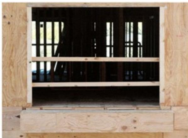
Fig. 5.26 - la corretta concezione e costruzione di un nodo “balcone” inizia con il creare un dislivello tra la sua soletta ed il solaio interno e nel realizzare una pendenza della soletta verso l’esterno del fabbricato.
