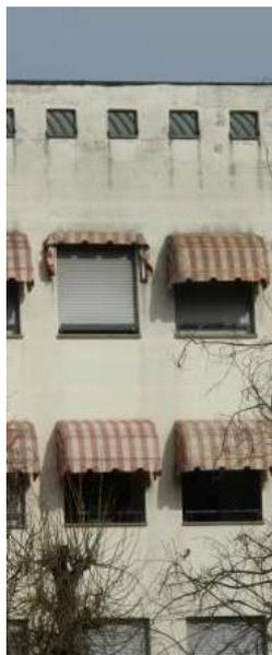
Fig. 5.18 – si notino i baffi neri nella parte alta dell'edificio in corrispondenza delle finestre
