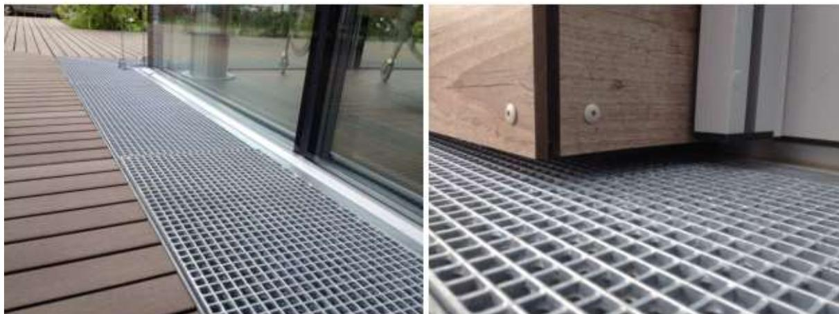
Fig. 5.1 – Esempio posa di grigliato nell'intorno dell'attacco a terra dell'edificio
