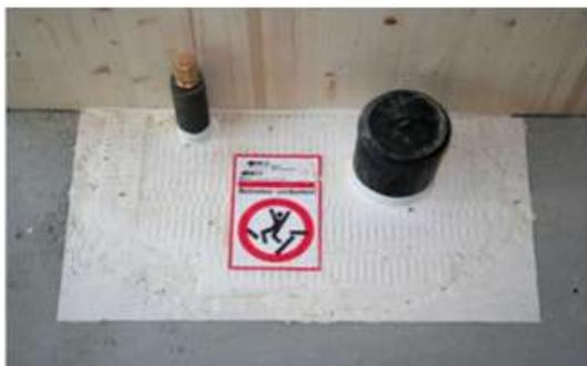
Fig. 6.16 – Cavedio correttamente concepito per la sicurezza in caso di incendio (materiale incombustibile a protezione del passaggio impiantistico)
