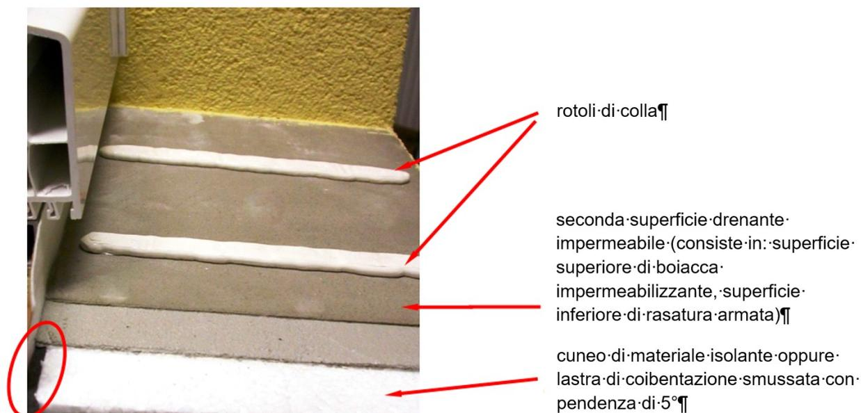
Fig. 5.17 - rotoli di colla sulla seconda superficie drenante, sui quali viene incollato il davanzale. Le intercapedini tra i rotoli di colla sono ammissibili. Il raccordo del cuneo di materiale isolante / lastra di facciata con il profilo di raccordo del davanzale avviene tramite nastro sigillante
