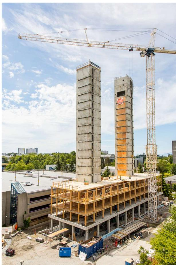
Fig. 7.5 – Step di cantiere: realizzazione delle componenti in c.a. e primi piani in legno
