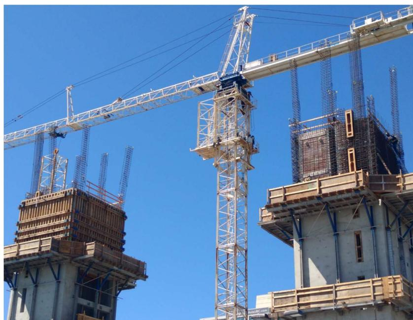
Fig. 7.7 – fase di realizzazione dei nuclei in calcestruzzo (Courtesy British Columbia)
