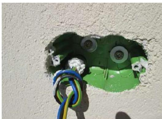
Fig. 6.34 – Cavo elettrico esterno e sigillatura
