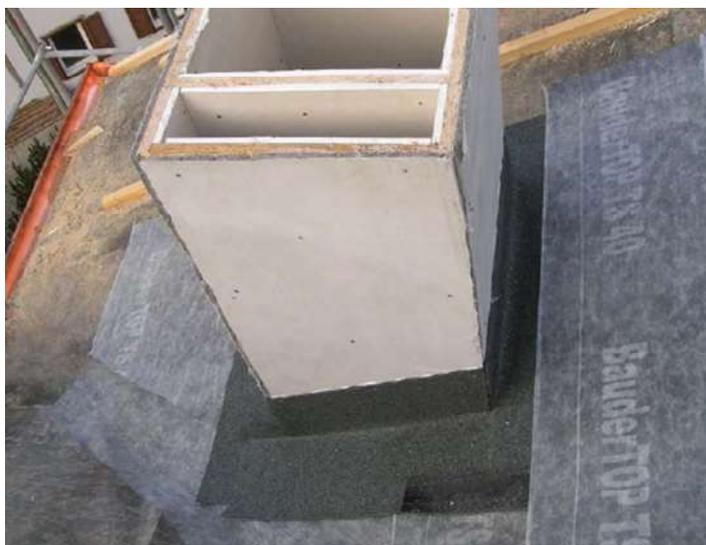
Fig. 5.61 – posa della guaina impermeabile (esempio)
