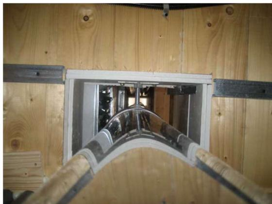
Fig. 5.52 – Passaggio camino in struttura a pannelli portanti
