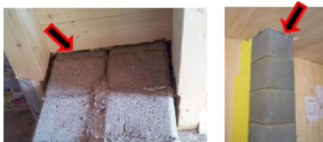
Fig. 5.47 - Esempi di camini previsti per combustibili solidi non eseguiti correttamente: ignorata completamente la distanza di sicurezza dai materiali combustibili
