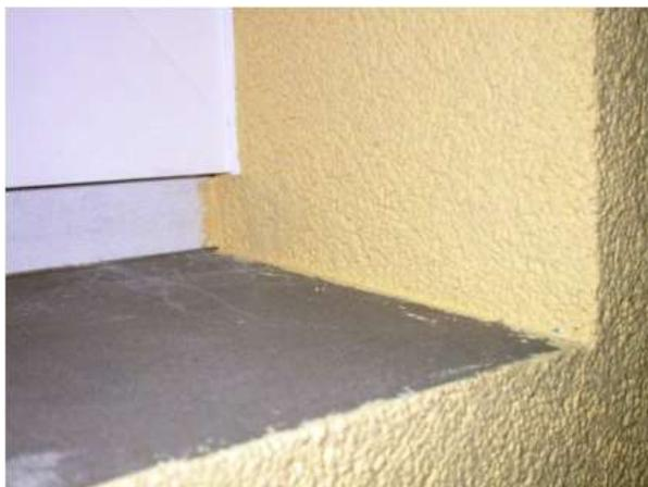
Fig. 5.20 – seconda superficie impermeabile del parapetto trattato finito
