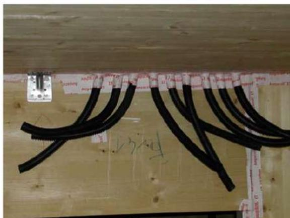
Fig. 6.31 – predisposizione impianto elettrico
