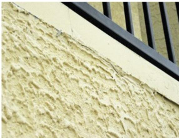
Fig. 5.29 - Zone di marcescenza del legno possono essere localizzate in prossimità dei gocciolatoi; nella figura sopra riportata infatti non è visibile l'estremità del gocciolatoio stesso. Questo favorisce l'ingresso di acqua dietro l'intonaco
