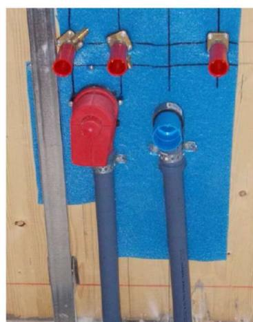
Fig 6.40 – protezione dalle condense tramite interposizione della guaina
