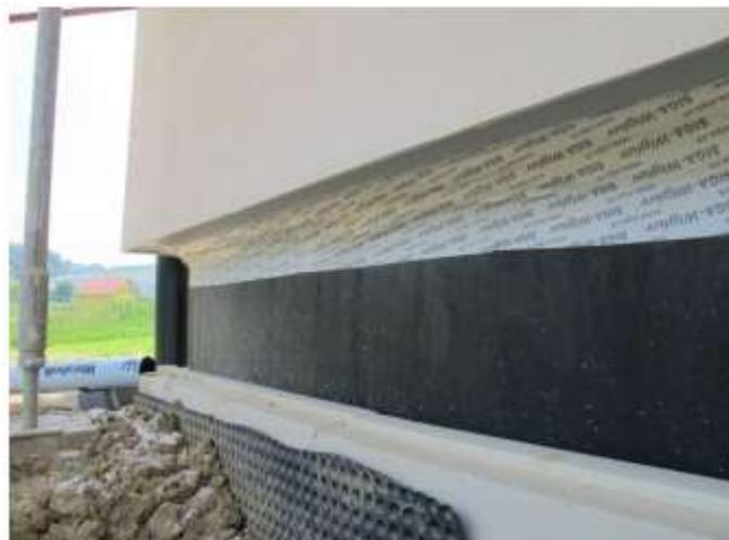
Fig. 5.2 – Sigillatura del giunto parete esterna / cordolo di attacco a terra tramite nastratura (prima del montaggio della coibentazione della zoccolo quale elemento ad innesto)
