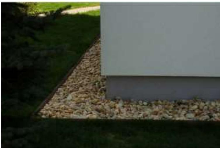
Fig. 5.10 – Zoccolatura ben arretrata; si noti lo strato di ghiaia intorno all'edificio per assicurare una ridondanza delle misure di protezione alla struttura che assicura un drenaggio delle acque meteoriche.
