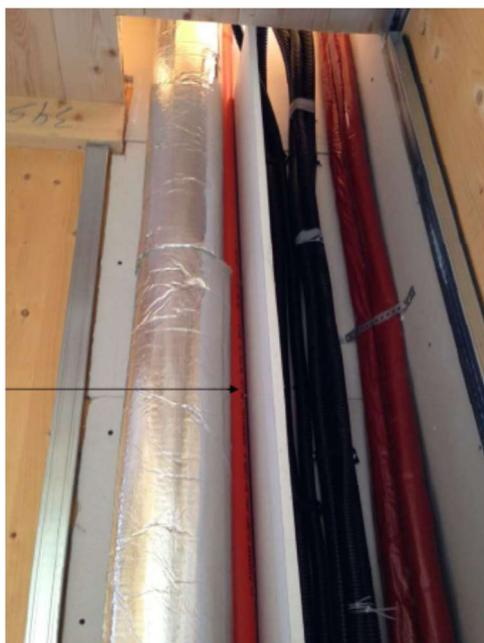
Fig. 5.56 – passaggio tubi (vedi freccia nera) nel passaggio camino; non permesso
