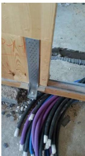
Fig. 6.25 – Comportamento errato e mancato schema impiantistico - Passaggio impianti con scasso del cordolo e assenza di appoggio per hold-down
