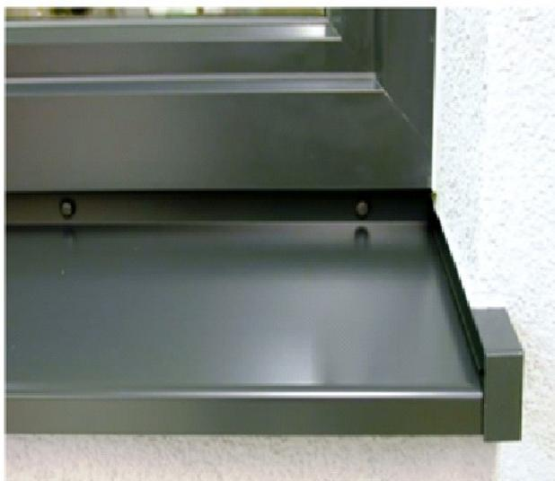
Fig. 5.19 – esempio di bancale in alluminio
