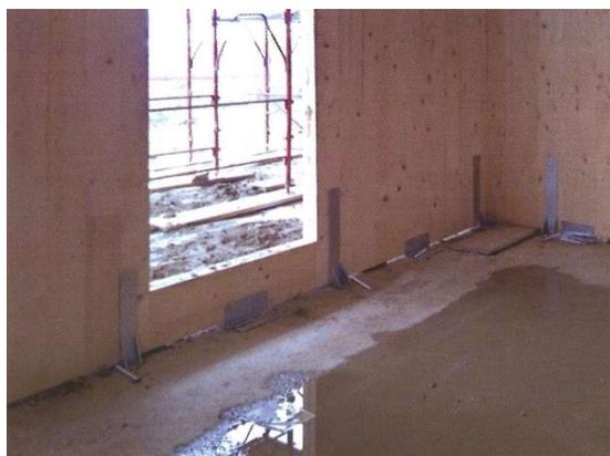
Fig. 5.4 – Attacco a terra non corretto; la parete in CLT è stata posata direttamente sulla platea senza una guaina di separazione.
