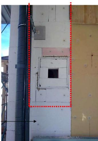
Fig. 5.54 – posa di materiale isolante incombustibile in prossimità del passaggio del camino (vedi freccia nera) in sostituzione alla fibra di legno
