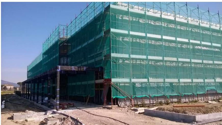
Fig. 6.9 – Protezione del perimetro esterno dell'edificio con teli impermeabili traspiranti.
