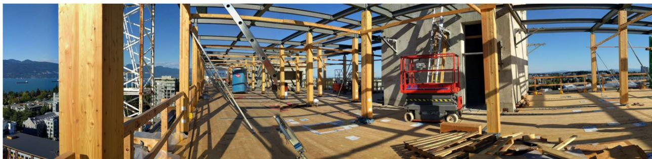
Fig. 7.3 – Brock Commons: fase di cantiere (courtesy British Columbia University). Altezza dell'opera 53m (18 piani); area di cantiere (2.315 m<sup>2</sup>)
