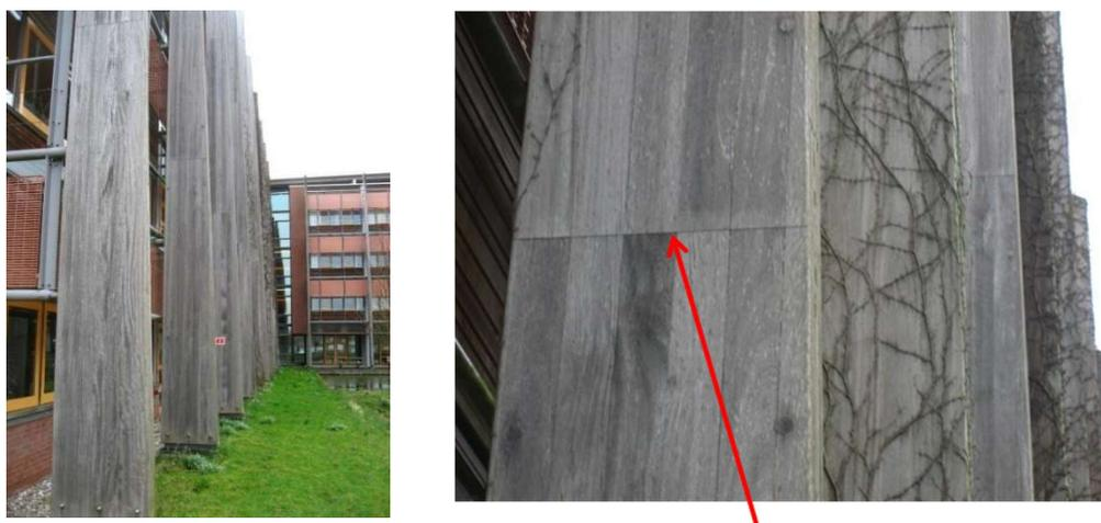
Fig. 4.22 (a÷b) –Lamellare di Iroko (Olanda )con giunti a tutta sezione; Nessuna delaminazione (classe di servizio 3) - Struttura esposta (15 anni)
