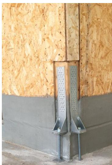
Fig. 5.3 – Sigillatura del giunto parete esterna / cordolo di attacco a terra tramite guaina liquida. Si veda nel presente caso la disposizione degli hold-down (posizione corretta in quanto soggetti a “lavorare a trazione” e non a compressione)
