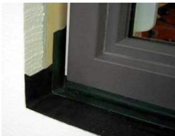
Fig. 5.22 – seconda superficie drenante, a forma di vasca, fissata al telaio della finestra tramite guaina e nastro adesivo. Sussiste in questo caso la possibilità di rialzare lateralmente la membrana sulla spalletta
