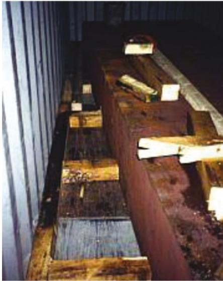
■ Fig. 44 - Bloccaggio trasversale di una lastra d'acciaio
