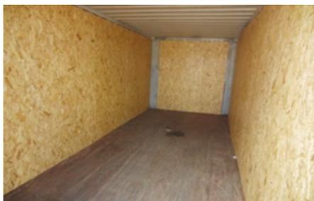
■ Fig. 52 - Container da 40 piedi rivestito con pannelli di OSB
