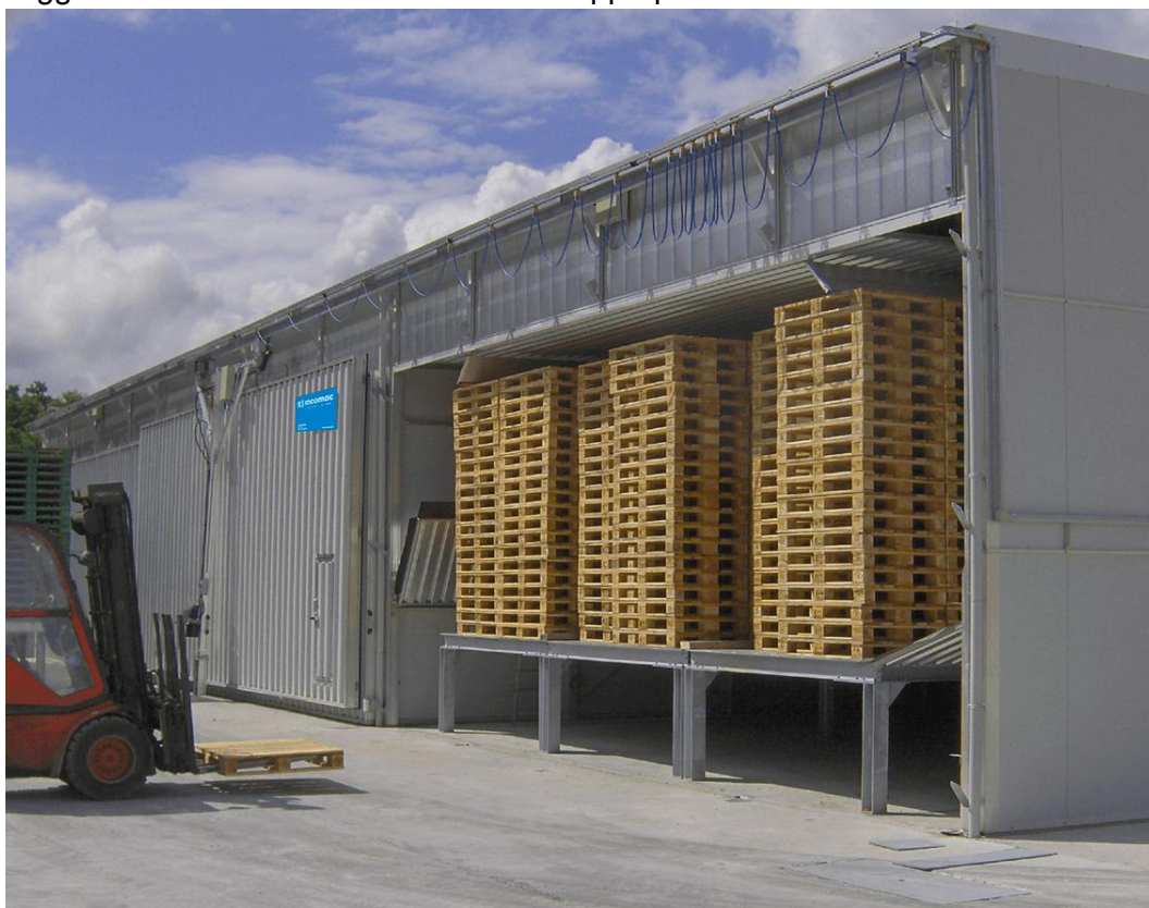
Foto 117 - Esempio di cella di essiccazione in muratura
