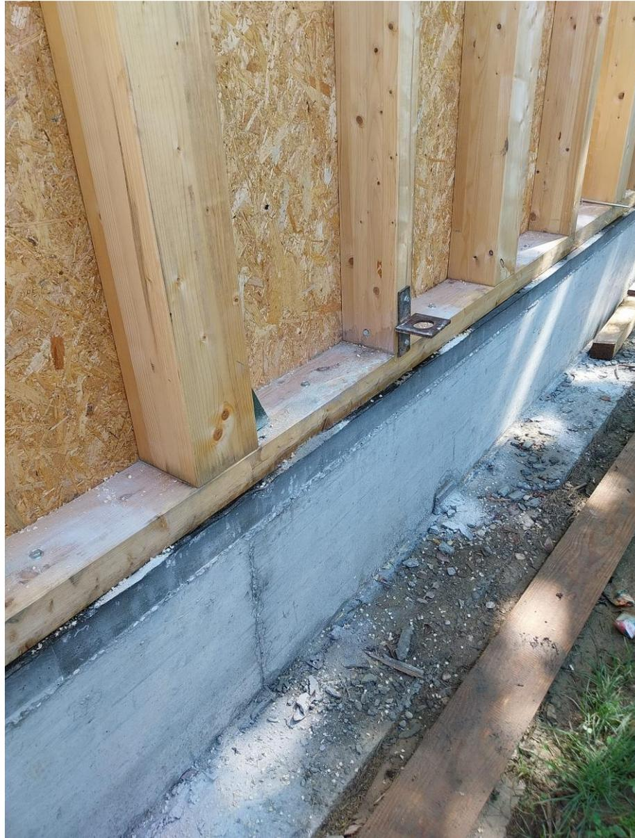
All'interno del telaio si inserisce l'isolante, solitamente lana di roccia e si completa all'esterno per protezione alle intemperie con adeguato cappotto anche di modesto spessore.
